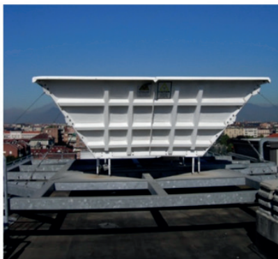
Figura 2: WPR a 915 Mhz di Arpa Piemonte a Torino
